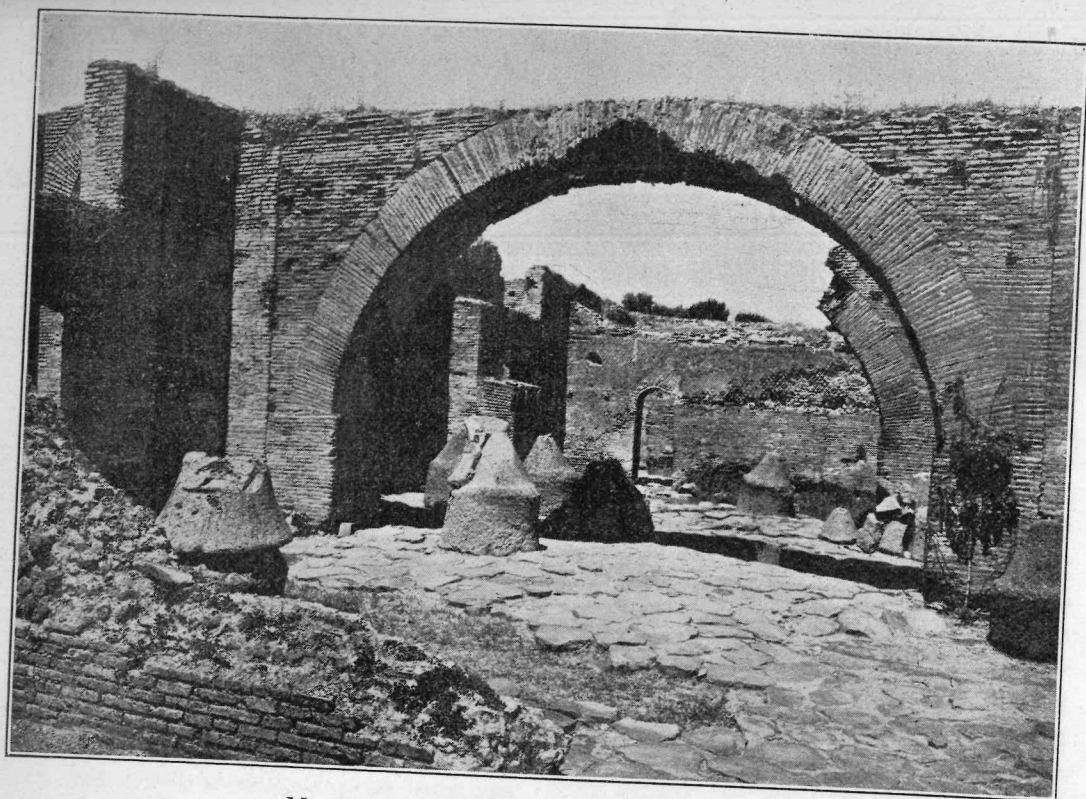
Macina per grano nell'edificio dei molini (Ostia).
