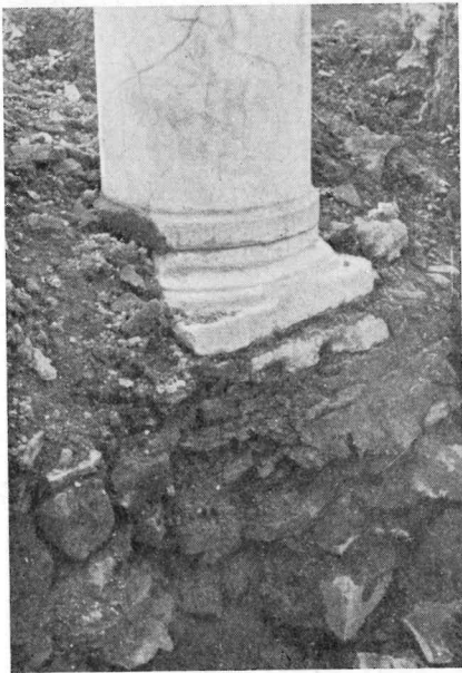
Fig. 3 - Lato interno della fondazione delle colonne tra Basilica e Battistero
