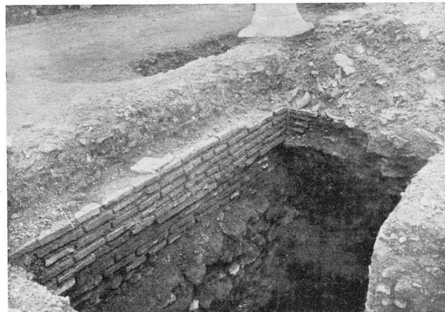
Fig. 6 - Parete occidentale delle Terme (lato interno) su cui sono state poste le colonne della navata della Basilica
