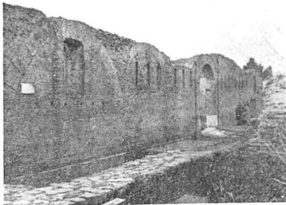
FIG. 3. - FACCIATA DELLA CASERMA DEI VIGILI
