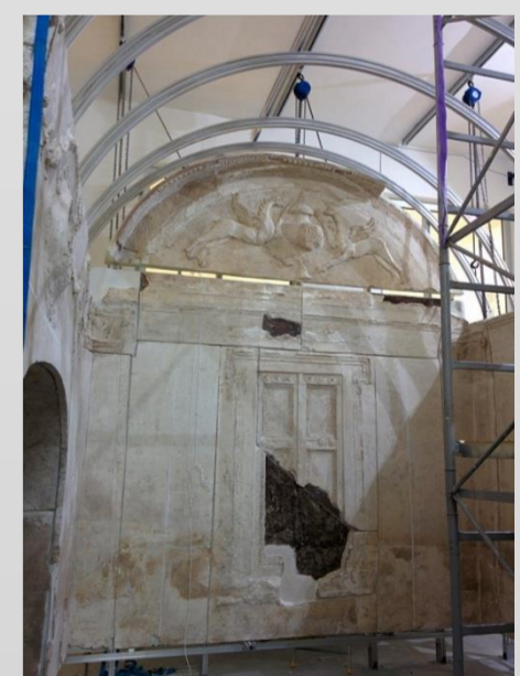
Assemblaggio e ancoraggio dei pannelli alla struttura di sostegno.
