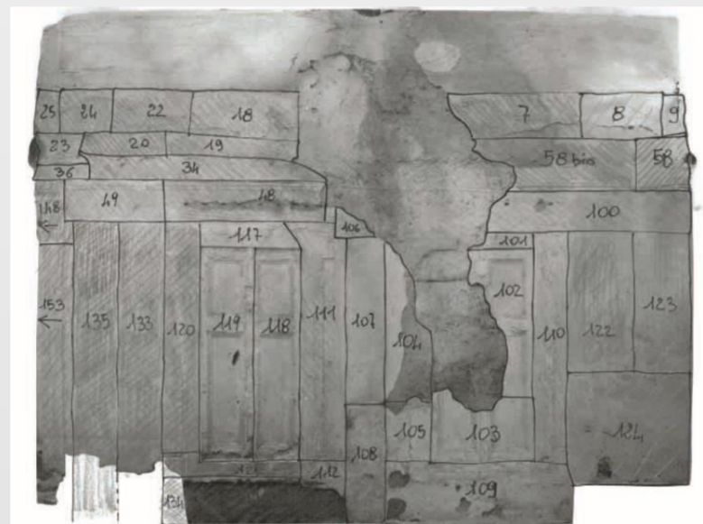
Schema dei tagli in cui è stata sezionata la parete ovest.
