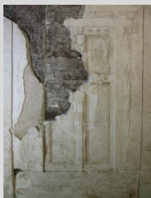
Preparazione del fondo del pannello con argilla espansa.
