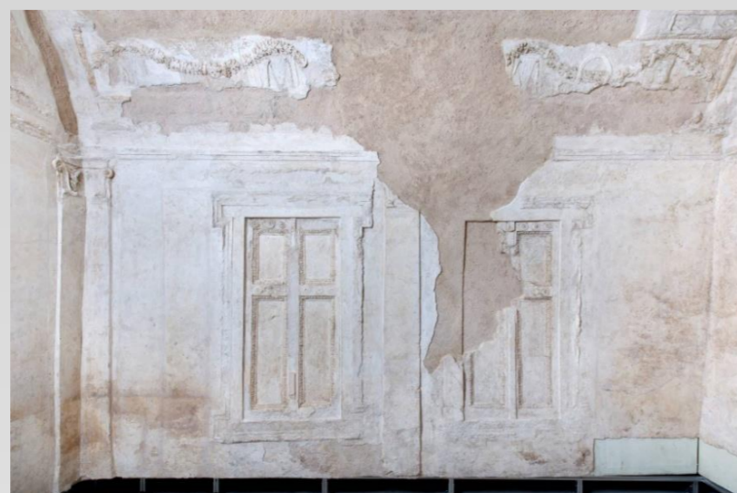
Parete ovest dopo il restauro.
