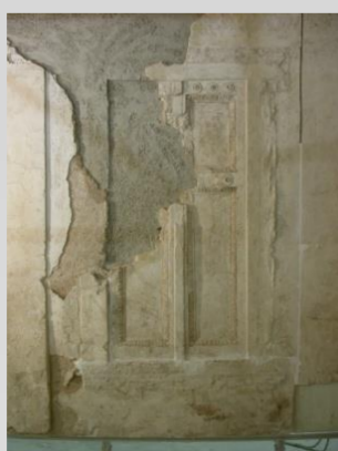
Rinzafo con malta idraulica e suggerimento a livello dell'arriccio, come in origine, del piano di fondo della finta porta.
