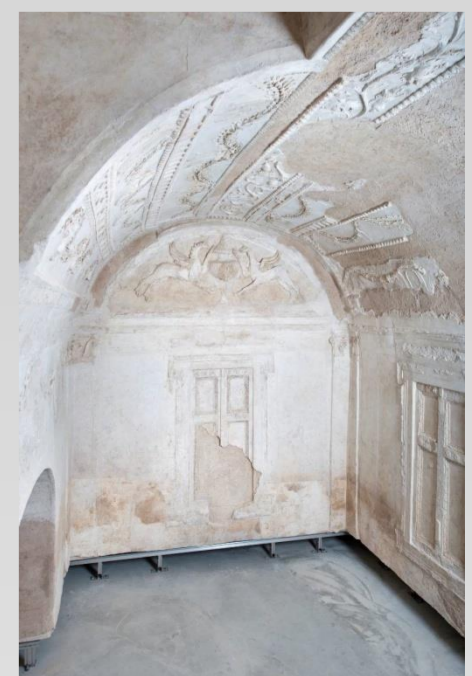
Parete sud dopo il restauro.
