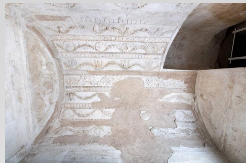
Volta dopo il restauro.
