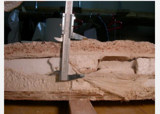
Col taglio realizzato per lo stacco, si apprezza la composizione degli impasti delle malte, il loro spessore piuttosto variabile e la tecnica impiegata per creare gli aggetti direttamente sullo strato di stucco liscio senza alcuna armatura interna.
